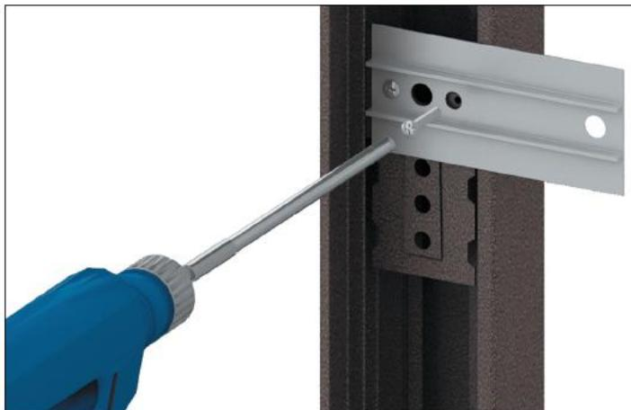
Закрепите монтажные пластины при помощи саморезов на раму под углом 90° через отверстия в анкерной пластине. С левой и правой сторон рамы устанавливается по 3 монтажные пластины.
