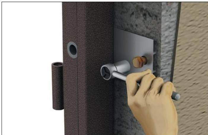
Просверлите отверстия в местах крепления пластин глубиной 100–150 мм. Диаметр сверла зависит от диаметра крепежного элемента. В просверленные отверстия установите анкерные болты и затяните их торцевым ключом.
