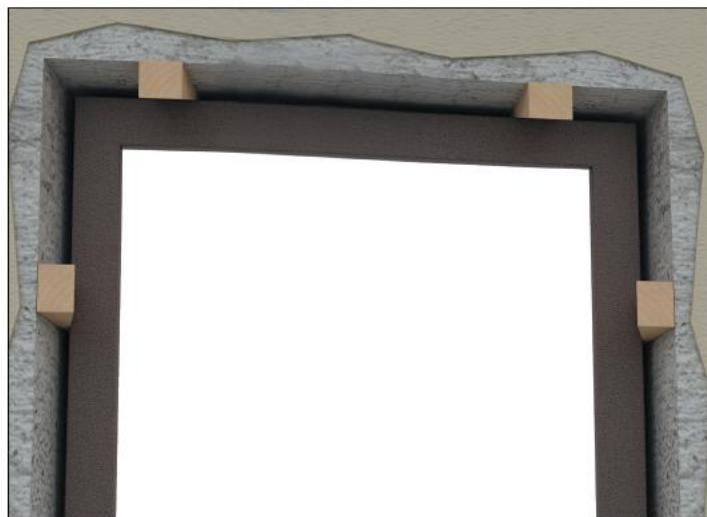
Проверьте установку рамы двери при помощи строительного уровня.
