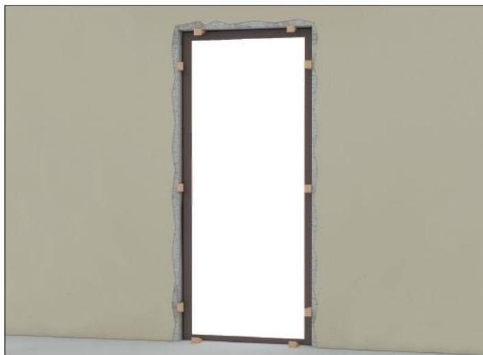
Установите раму в проем. Выставите раму по уровню, фиксируя ее в проеме с помощью распорных клиньев. Установите клинья между стеной и рамой с внутренней стороны двери.
